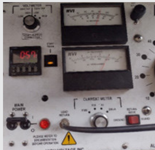
Figura 8. Inyección de voltaje y corriente de fuga durante la prueba dieléctrica a un equipo hidráulico con barrena.
