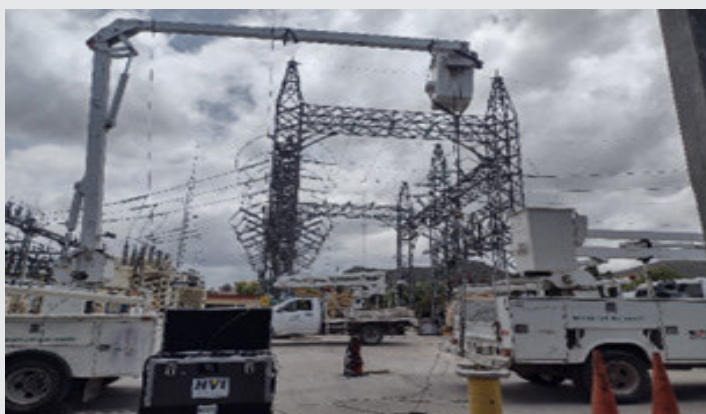
Figura 12. Instrumentación del ensayo de Emisión acústica a un equipo hidráulico.
